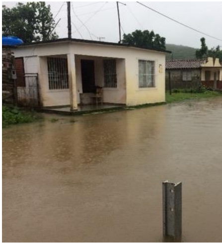
Les récentes fortes pluies ont provoqué d'impressionnantes inondations
